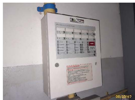
แผงควบคุมสัญญาณฉุกเฉิน
