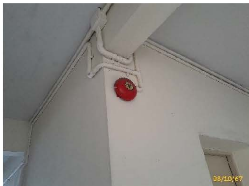
อุปกรณ์ส่งสัญญาณเตือนแบบกริ่ง
